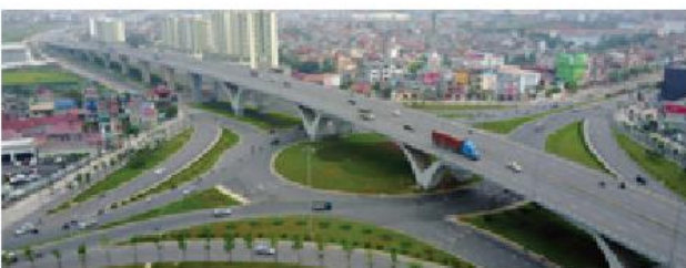
Hình 9.4. Cầu vượt thép tại nút giao Nguyễn Văn Cừ quận Long Biên, Hà Nội
