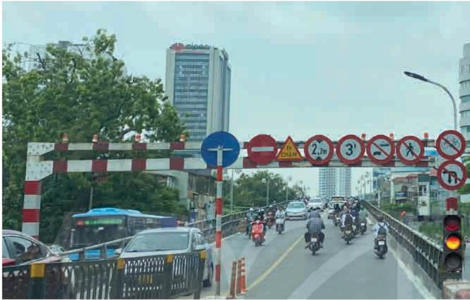
Hình 7.82. Tại đầu một số cầu vượt ta có thể bắt gặp khung khống chế chiều cao.
